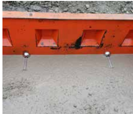
3 Der Anker wird vollständig gegossen. Achten sie darauf, während dass vibrieren.
