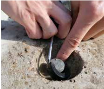
5 Entfernen sie den Gummi vom Anker.
