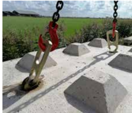
6 Befestigen sie die Haken an den Ankern und die Last kann angehoben werden.
