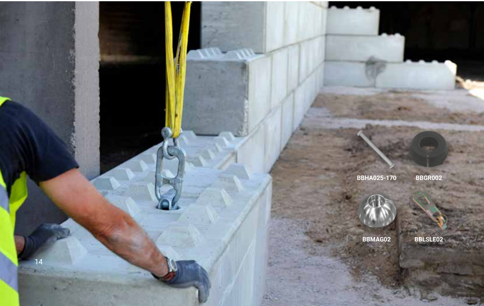
6 Befestigen sie die Haken an den Ankern und die Last kann angehoben werden.
