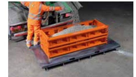
3 Der Beton gießen.
