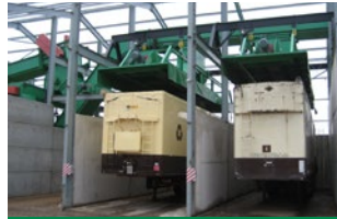
LKW-Beladung Be- & Entladung
